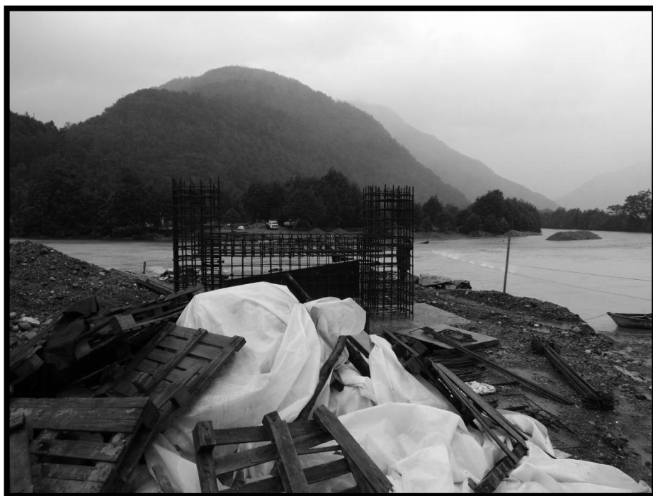
Figura 30: Fotografía de la construcción de la pasarela que atraviesa la confluencia de los tres ríos; Exploradores, Oscuro y Teresa. Última Etapa del camino que une Bahía Exploradores y Puerto Río Tranquilo (Ruta X-728)
