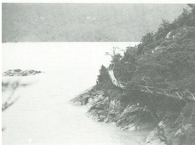
Figura N° 22. Vista de las primeras pasarelas de caleta Tortel
